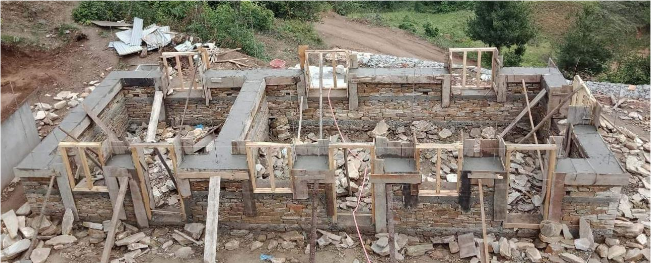
Abb. 8 Als Zwischenlagen werden betonierte Bänder in die traditionelle Steinmauer eingebracht um die Erdbebensicherheit zu gewährleisten.
