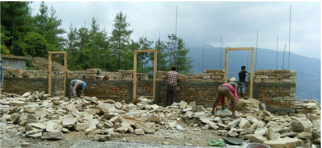
Abb. 7 Beginn der Bauarbeiten im Sommer 2019.
