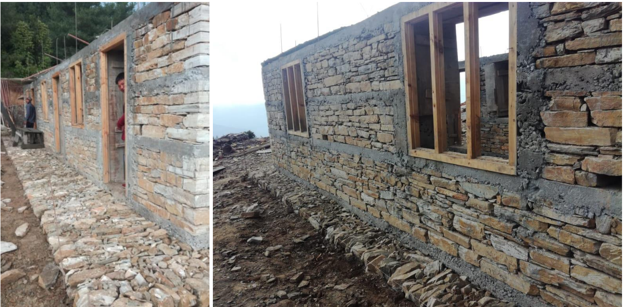
Abb. 9 Die Steine für den Bau stammen aus einem nahegelegenen Steinbruch, das Holz aus dem dorfeigenen Wald. Alle Holzarbeiten wurden von Sange Sherpa durchgeführt, der ebenfalls mit seiner Familie im Dorf wohnt. Links: Phurba Sherpa, der ebenfalls Mitglied im Dorfkomitee ist, arbeitet tatkräftig als Maurer.
