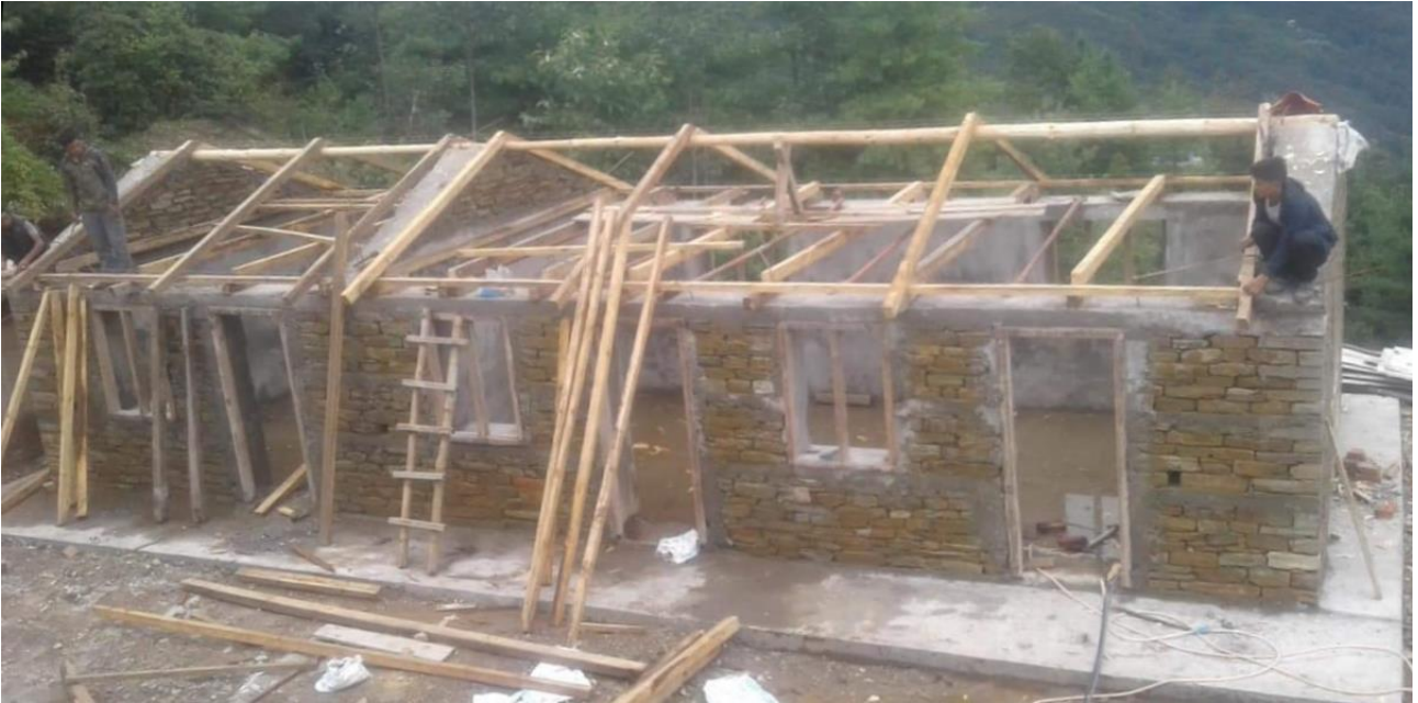
Abb. 10 Der Dachstuhl wird errichtet.
