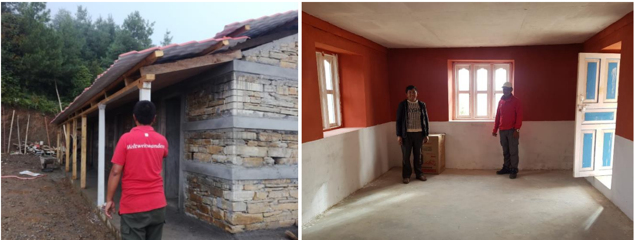
Abb. 12 Links: Sonam Sherpa bei den letzten Gestaltungsarbeiten. Rechts: Suku Sherpa (Finanzverantwortlicher des Dorfkomitees) und Sonam Sherpa besichtigen das fertiggestellte Gebäude.
