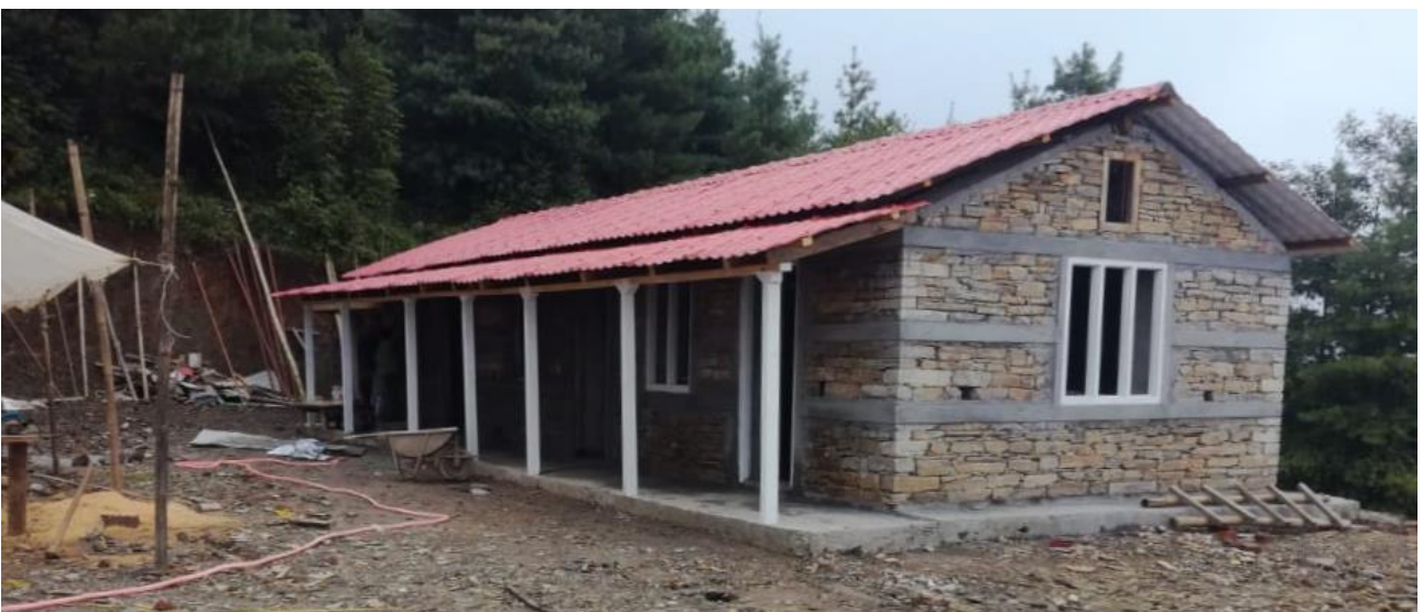
Abb. 11 Das Dach wird eingedeckt und ein Laubengang errichtet. Dieser ist vor allem in Monsunzeiten sehr wichtig.
